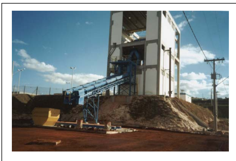
FIGURA 4.4 – Vista do prédio da centrífuga
