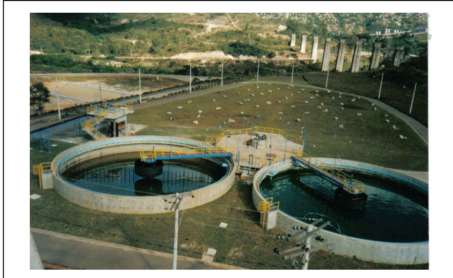
FIGURA 4.2 – Vista dos adensadores por gravidade
