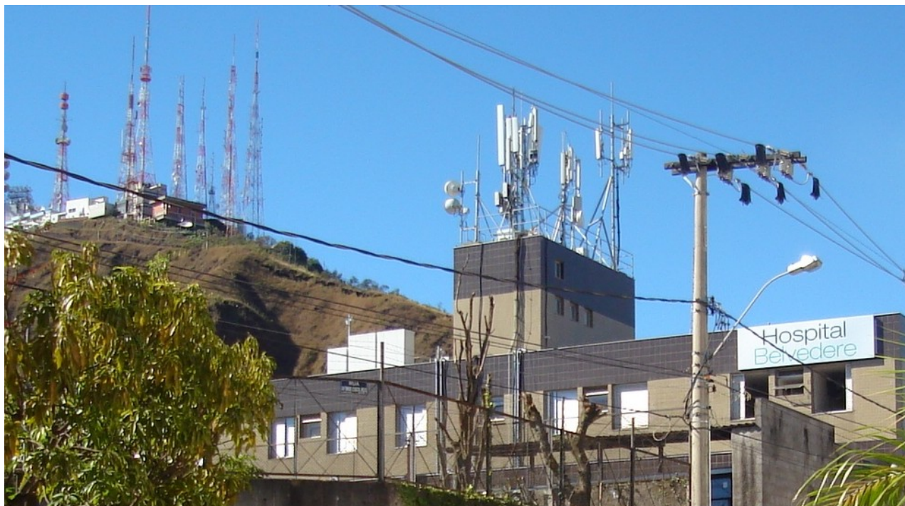
Figura 3.1 – Antenas de Telefonia Celular - Bairro Belvedere - Belo Horizonte-Minas Gerais.
