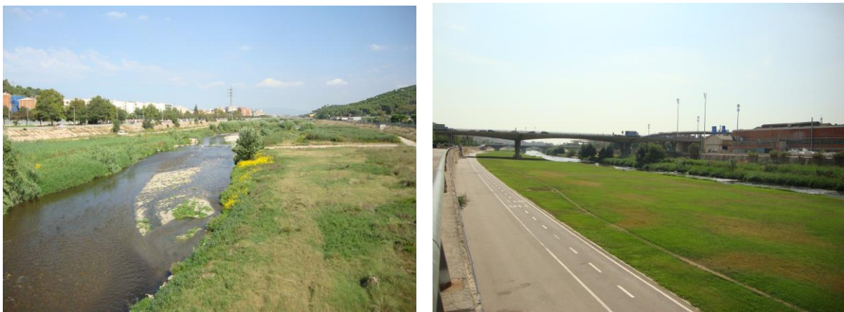
Figura 7.7 – Intervenção em uma dada extensão do Rio Besòs: trecho de montante (foto da esquerda) e de jusante (foto da direita)
