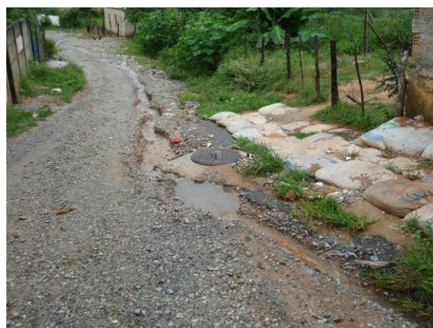
**FIGURA 5.10:** Via sem estrutura de drenagem e utilização de cascalho – Vila Nova Esperança – 12/2008.
