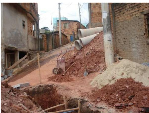
**FIGURA 5.13:** Implantação de rede de esgotamento sanitário.
