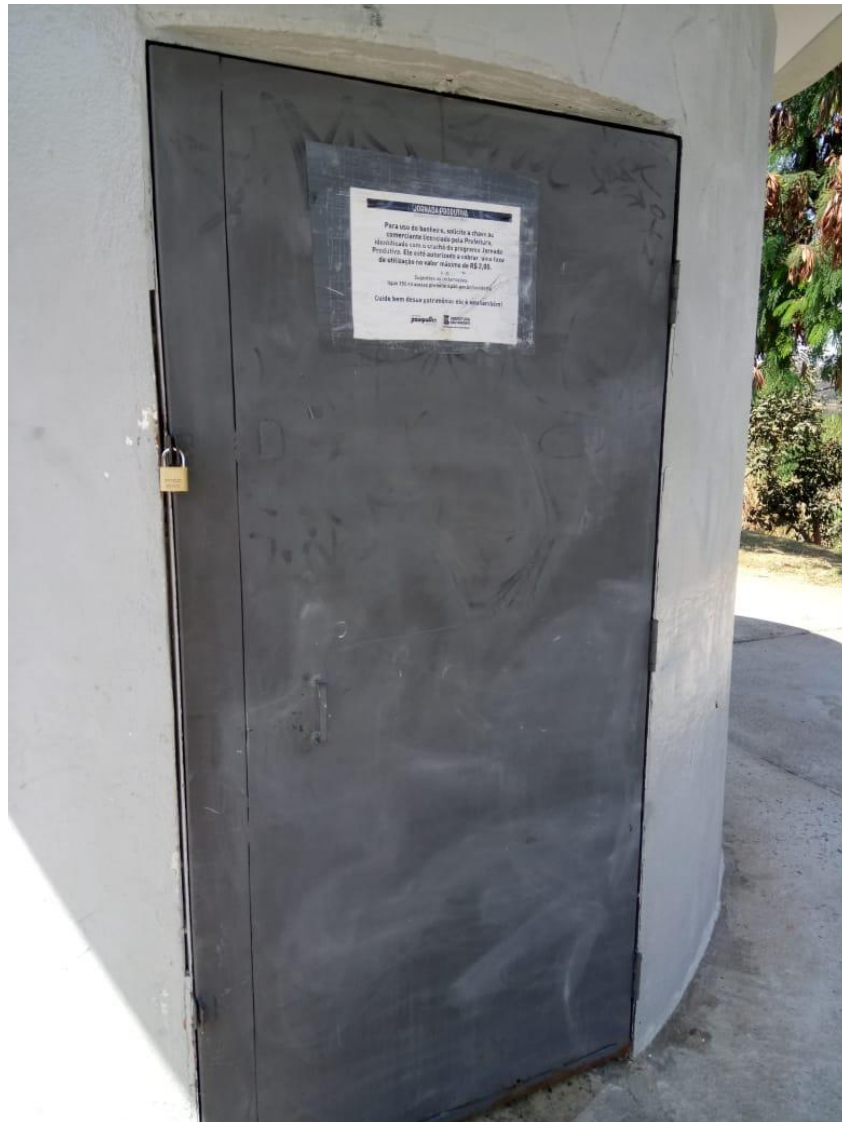
Figura 15 : Banheiro no Mirante das Garças (Ponto 6) com placa informativa sobre o serviço
