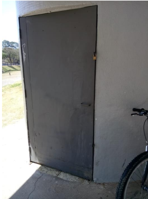
Figura 14: Banheiro público do Mirante Sabiá (Ponto 5) trancado com cadeado e sem sinalização.
