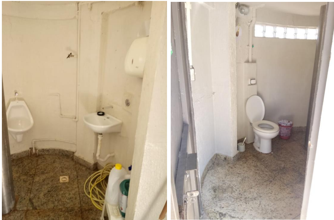
Figura 17: Imagens do interior do banheiro público no Mirante do Biguá (Ponto 7).
